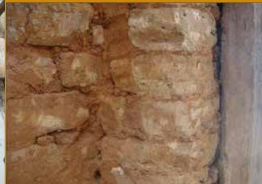
Fig. 4.13.c. Detalle de muro de adobe reutilizado y redondeado para jerarquizar el acceso a la Sacristía Norte, desde la galería.
