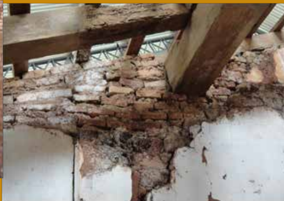
Fig. 4.13.a. Encuentros de muros. Ampliación de la Sacristía, reutilizando materiales antiguos y colocando muro de mampostería de ladrillo sobre el muro antiguo de adobe. En el maderamen que se observa la marca de haber estado asentado en un antiguo muro de adobe. Esto nos indica dos periodos constructivos con diferentes materiales, y que determinan las funciones originales de los
