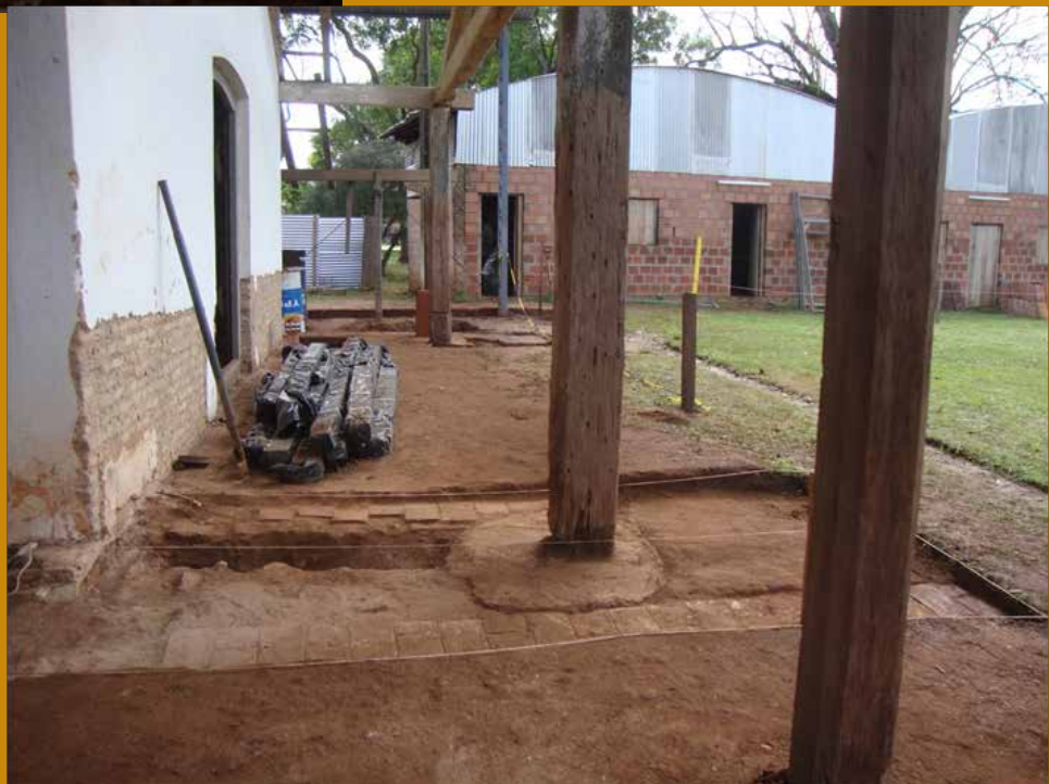
Fig. 4.26. Vista del Frontis de la Iglesia Antigua donde se observa el cateo realizado para la definición de la galería lateral y el frontis, así como sus pisos originales.
