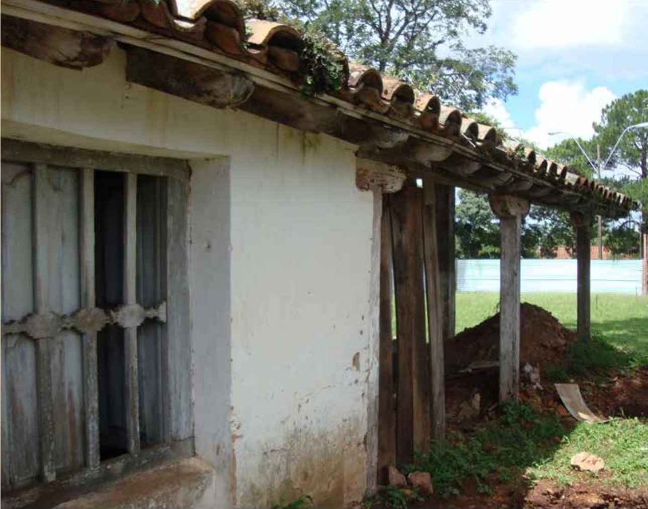
Fig. 4.27. Sacristía y Galería Sur de la Iglesia de San Miguel Arcángel. Nótese los detalles de la ventana, así como los horcones de madera de la galería.
