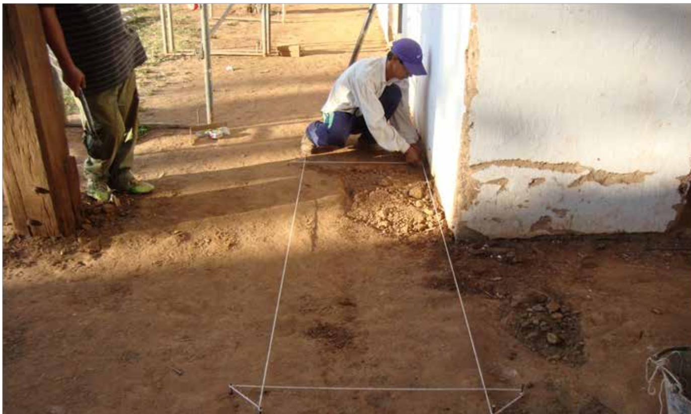
Figura 4.18 b. Demarcación de la calicata de sondeo.
