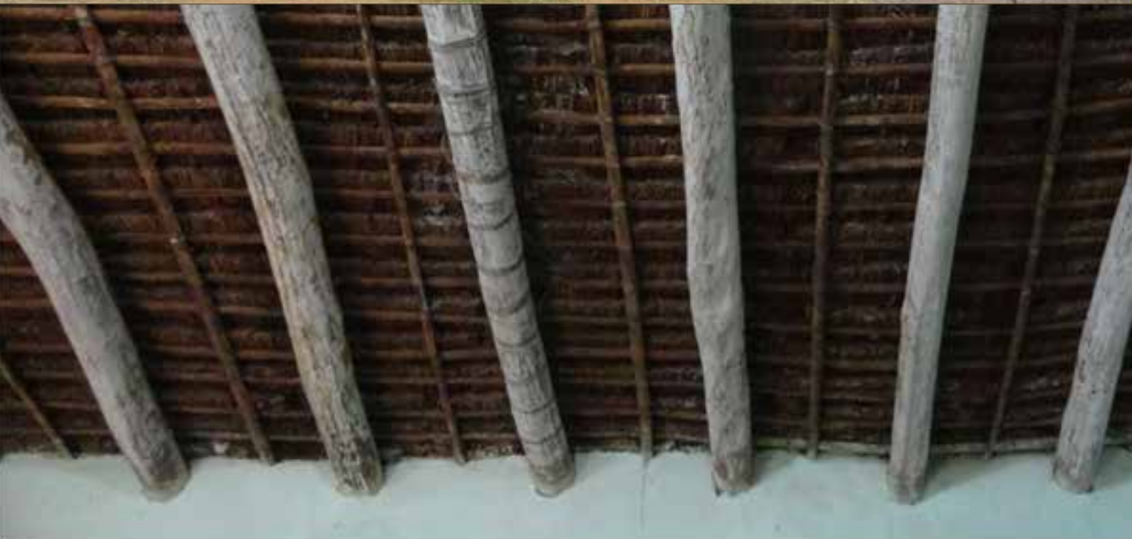
Fig. 1.2. Techo de vivienda del entorno de la Plaza e Iglesia, conservandose a la fecha, así como sus paredes de material de adobe. Esta vivienda mantiene su fundación original y totalmente de muros de adobe, ventanas de madera y piso.
