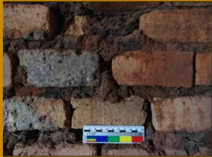
Fig. 4.8. Muro de mampostería Sacristía Sur (Lado oeste)
