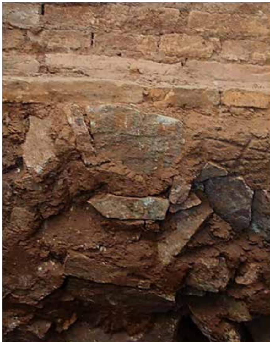
Fig. 4.15. Prospecciones arqueológicas - pared sur (38,5 cm) de la sacristía, sobre la cual descansa la cúpula, donde se observa el tipo de fundación de piedra (72,5 cm de profundidad del nivel inferior del piso), el nivel de piso y el arranque del muro de mampostería.
