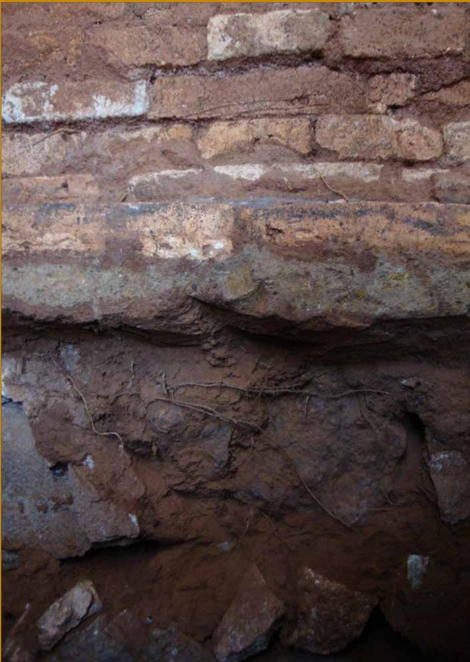
Fig. 4.10. Prospección arqueológica muro norte de la Sacristía, donde se observa el tipo de fundación, su nivel de piso y arranque del muro de mampostería.
