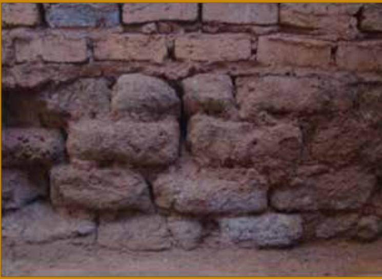
Fig. 4.7. Muro de mampostería Sacristía Sur (Lado Sur)
