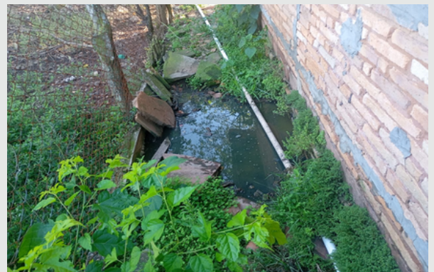
POZO SEPTICO ROTO VERIFICACION Y POSTERIOR NOTIFICACION AL DUEÑO PARA ARREGLAR
